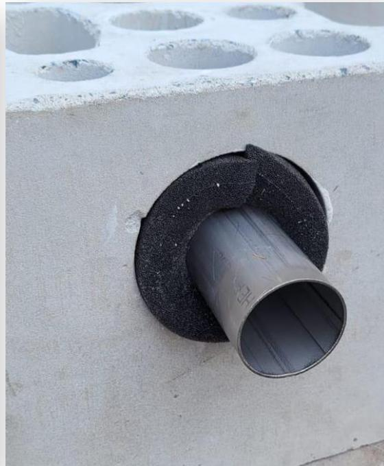
Ziehen Sie die Schutzfolie von den Fixierbandstücken ab und befestigen Sie das Band im Abstand der Wandstärke auf dem entsprechenden Schutzrohr der Einföhrung und drücken es fest zusammen. Das Fixierband muss komplett in der Bohrung sitzen wie in Bild 4. Durch das Rückstellvermögen zentriert das Band das Schutzrohr in der Kernlochbohrung und dichtet nach innen und außen ab.
